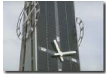
(그림 3.15) 부속건물벽에 설치된 태양전지
