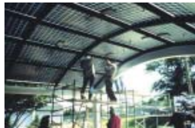
(그림 3.6) 아취형 지붕 설치
