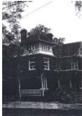
그림 5 빅토리아 건축은 건물을 차양하고 외부공간의 냉방을 위해 현관, 베란다, 발코니를 설치한다.
