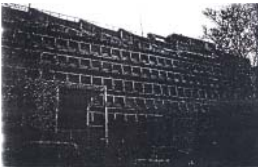
그림 11 brise-soleil이라는 차양장치를 새롭게 설치되었다.
