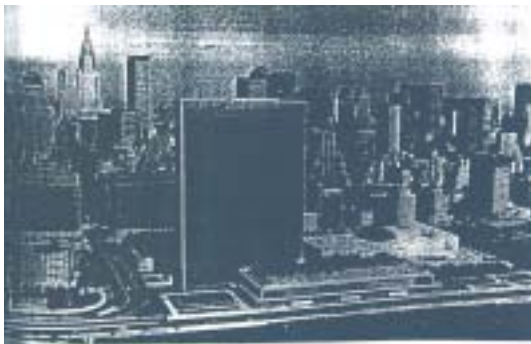
그림 77 1950년 뉴욕의 헤드쿼터 사무실 바닥은 많은 사무실 건물의 원형이 되었다. 르 꼬르뷔제가 아마도 유리 파사드의 대부분 동쪽과 서쪽으로 향해있고 차양에 의해 전혀 가려지지 않은 반면에 텅 빈벽은 대부분 북쪽과 남쪽을 향해있다는 것을 발견했다면 매우 화가 났을 것이다.
