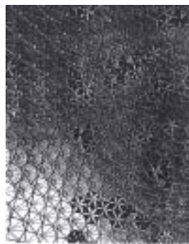
그림 49 엑스포 67'의 U.S 파빌리온은 Buckminster Fuller에 의해 디자인되었다. 내부에서 보는 돔의 이 모습은 상부의 구멍과 여름에 과열을 막는 삼각형의 롤 차광막을 보여준다.
