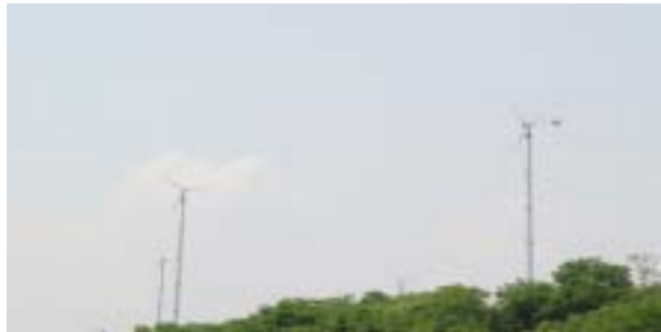
(그림 3.6) 난지도생태공원의 25kW급 풍력발전기
