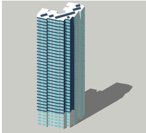
(그림 4.13) BIPV 설치 예시(203동)
