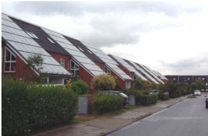
(그림 2.20) 브람펠트 단지 내 지붕에 설치된 집열판
