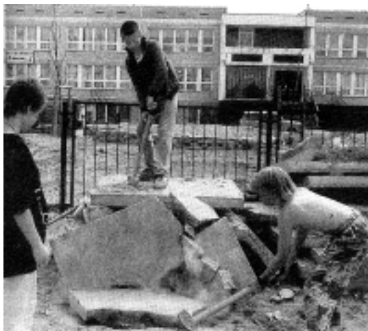
(그림 3.23) 콘크리트 포장제거, Hellersdorf
