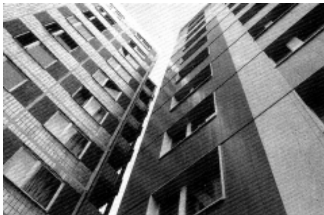
(그림 3.19) 주동 외벽 단열 공사전(좌) 후(우), Hellesdorf
