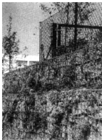
(그림 3.24) 폐골재 이용한 축대, Hellersdorf
