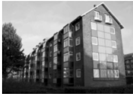
(그림 2.37) Solar Mass Wall과 난간에 Ventilated Solar Wall을 설치한서향의 부착온실, FLEXREN
