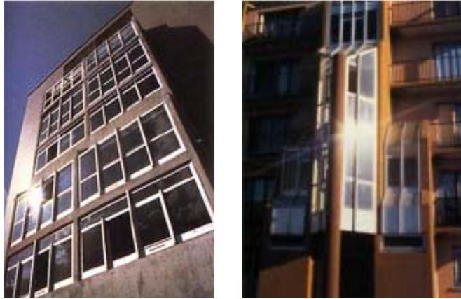
(그림 2.8) 축열벽의 설치 모습, Lievre d'Or
