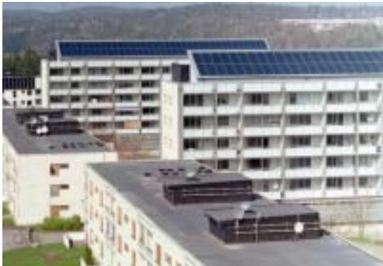
(그림 2.12) 태양열 집열관 설치 모습,
