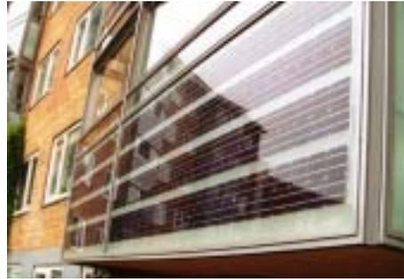
(그림 2.20) 발코니 설치 PV 모듈,
