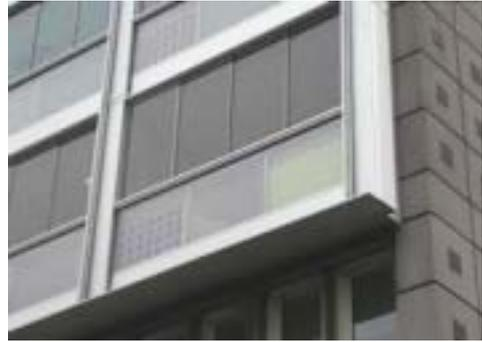
(그림 2.21) 발코니 설치 PV 모듈, Kollektivhuset
