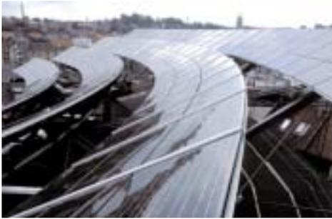
(그림 2.19) 지붕 설치 PV 모듈,
