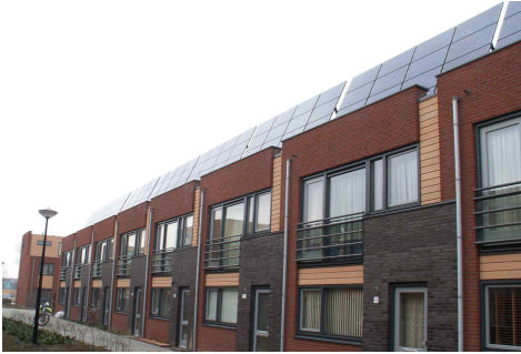
연립 주택에 설치된 독립형 PV
