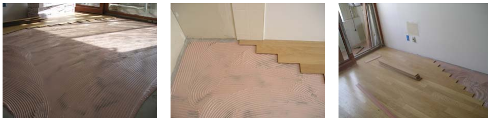
(그림 6.21) 온돌마루 시공
