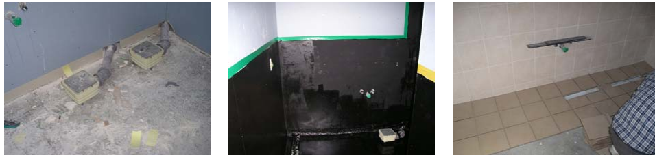
(그림 6.18) 욕실방수 및 타일 시공
