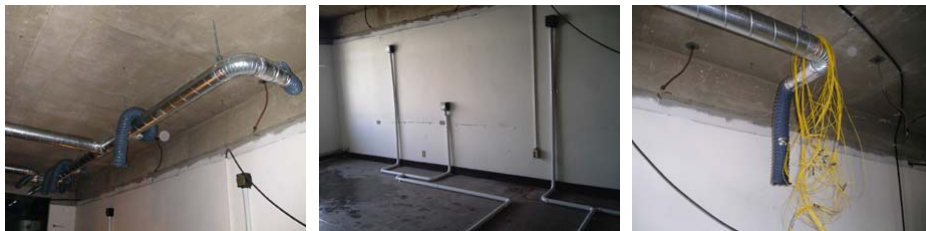
(그림 6.16) 환기시스템 시공
