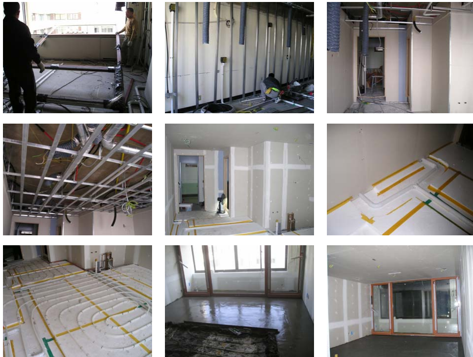
(그림 6.17) 벽체 및 바닥 시공
