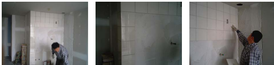
(그림 6.19) 주방타일 시공
