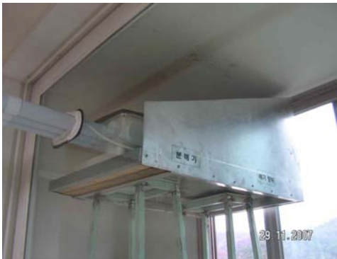
(그림 4.7) 창틀자연급기+덕트배기 환기시스템 설치 도면
