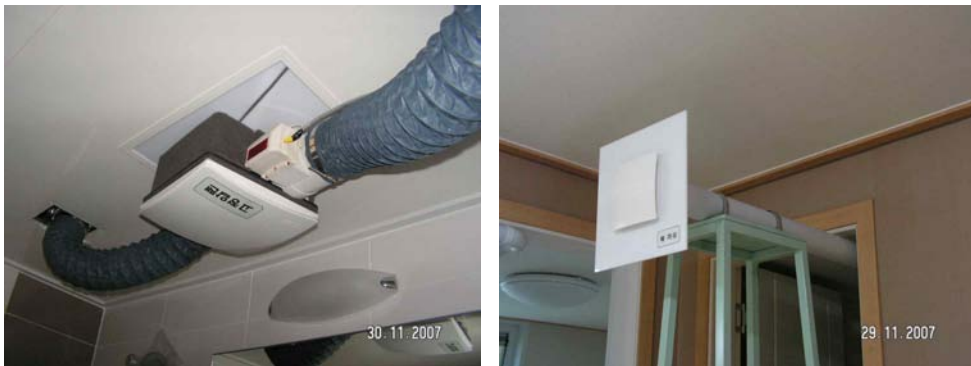
(그림 4.6) 창틀자연급기+욕실·거실배기 환기시스템 설치 사진
