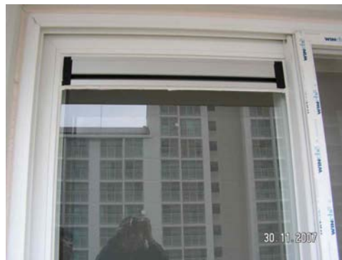
(그림 4.4) 창틀설치형 자연환기장치 내부와 외부에서의 설치 모습
