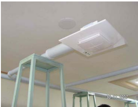
(그림 4.8) 창틀자연급기+덕트배기 환기시스템 설치 사진
