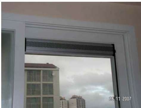
(그림 4.4) 창틀설치형 자연환기장치 내부와 외부에서의 설치 모습
